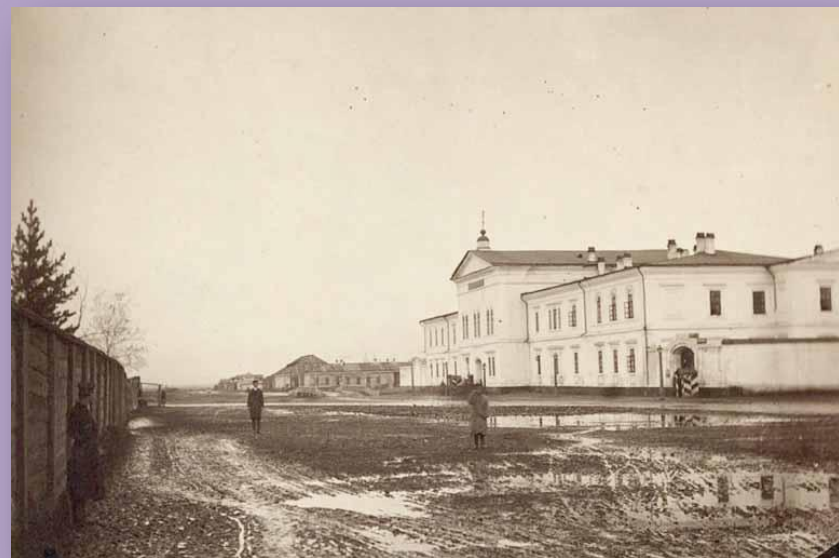
Иркутский тюремный замок
