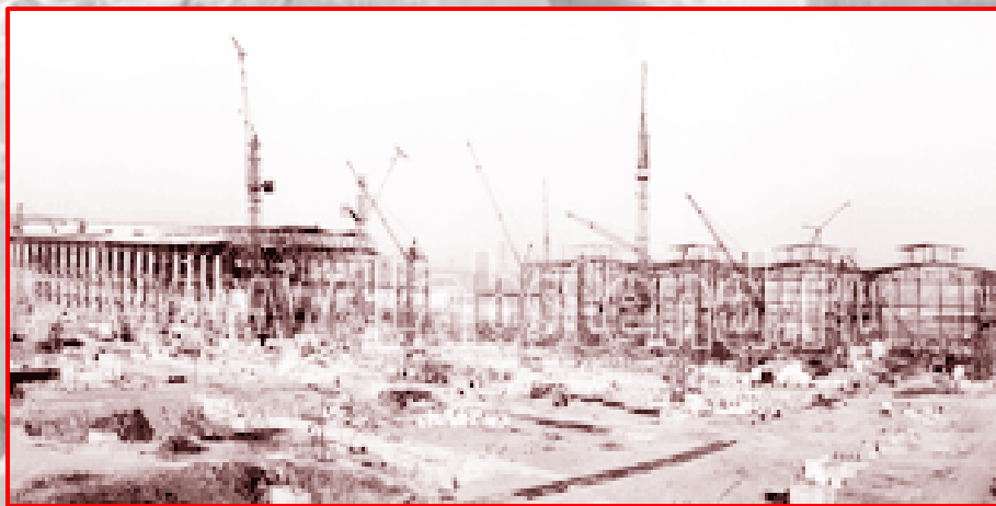
Строительство Челябинского металлургического завода
