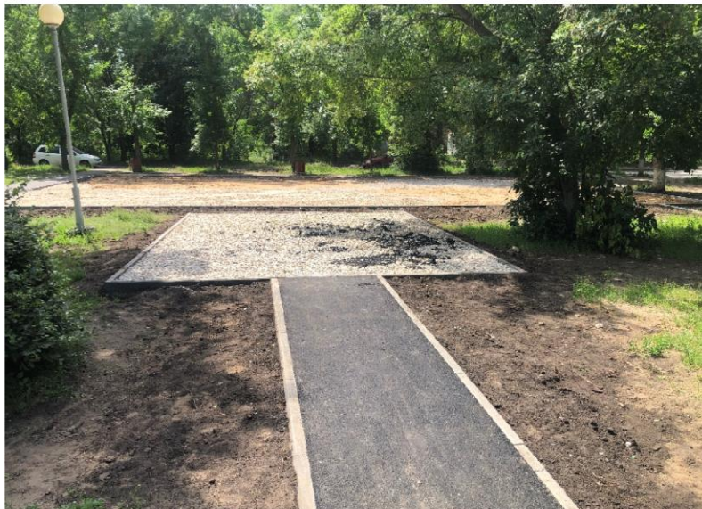
Фото объекта «В работе»
