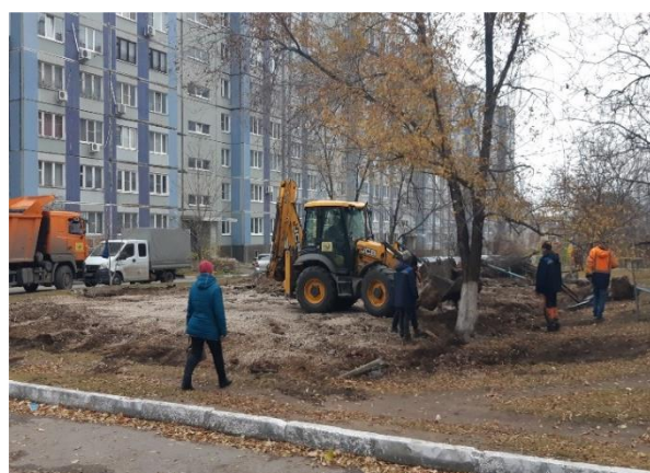
Фото объекта «В работе»
