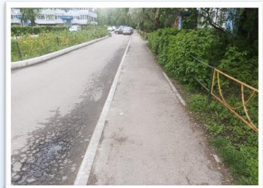
Фото объекта «До»
