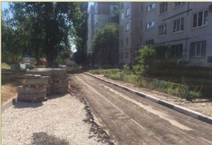
Фото объекта «В работе»
