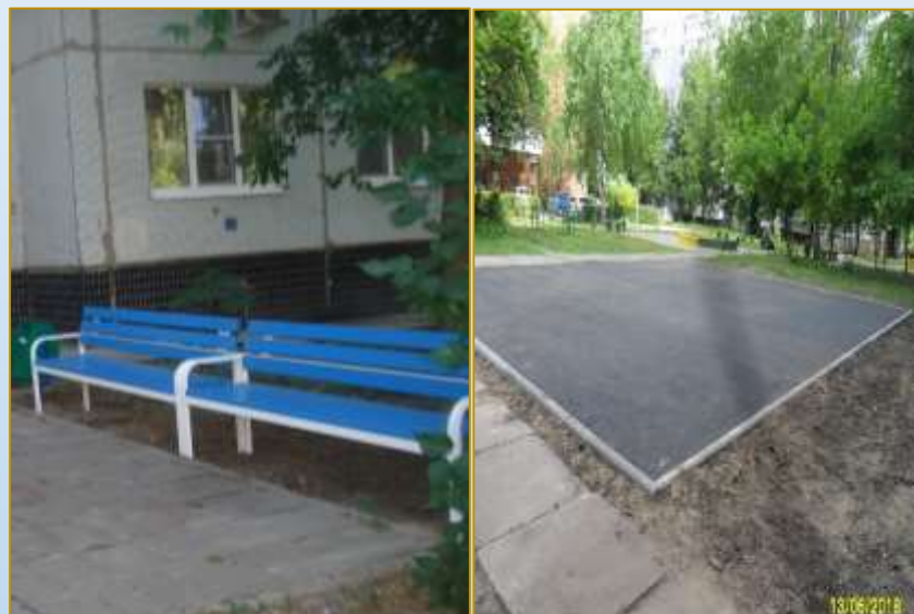
Фото объекта «В работе»
