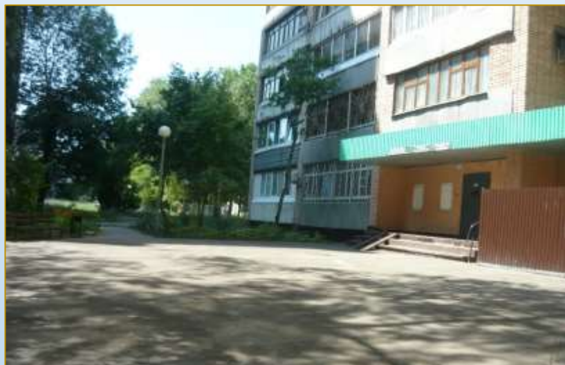
Фото объекта «До»
