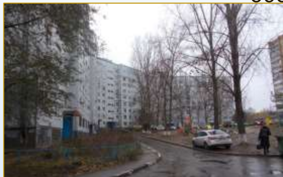
Фото объекта «До»
