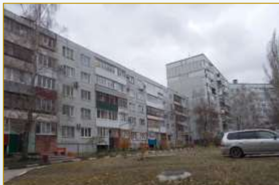
Фото объекта «До»
