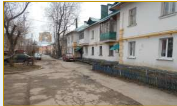
Фото объекта «До»
