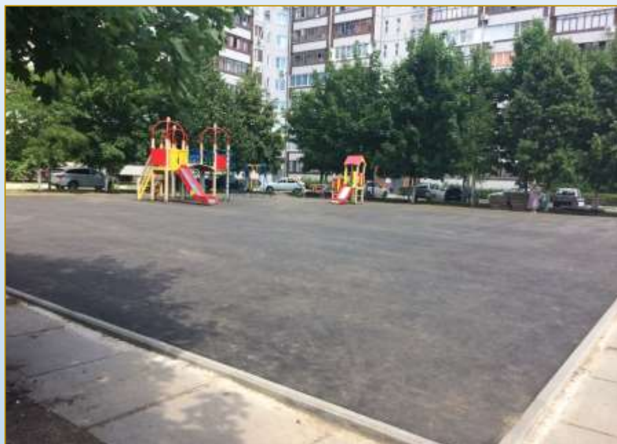
Фото объекта «В работе»
