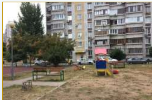
Фото объекта «До»
