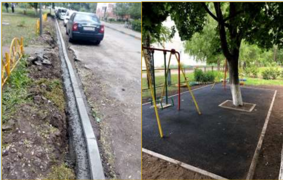
Фото объекта «В работе»
