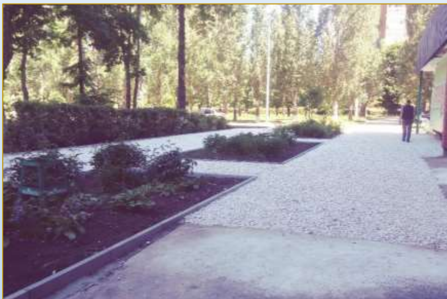
Фото объекта «В работе»
