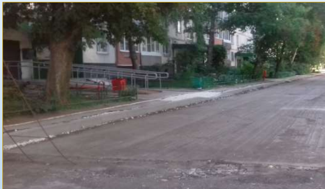
Фото объекта «В работе»
