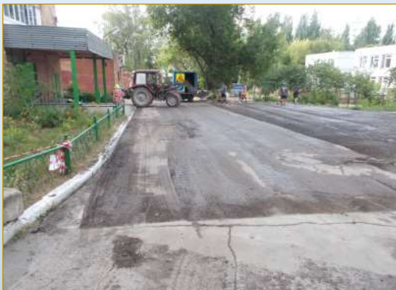
Фото объекта «В работе»
