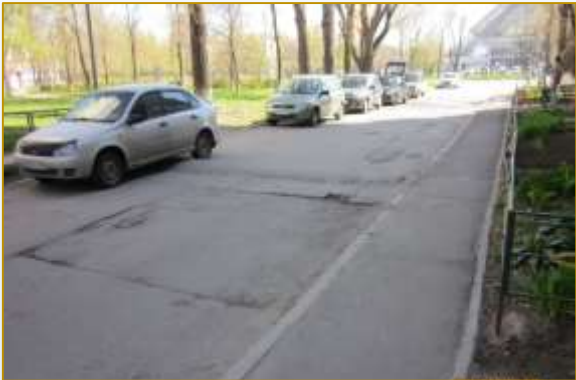
Фото объекта «До»
