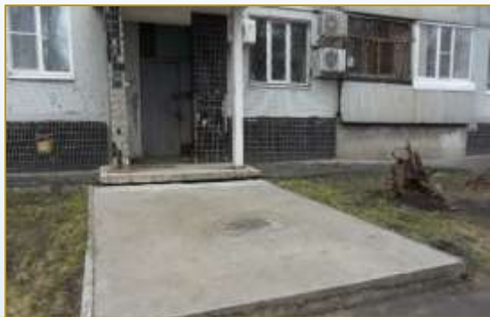
Фото объекта «До»
