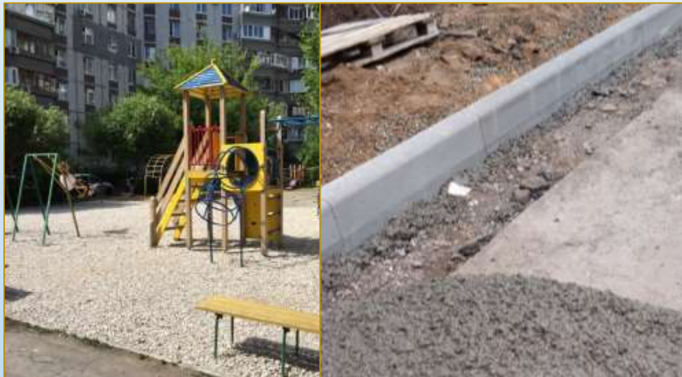
Фото объекта «В работе»
