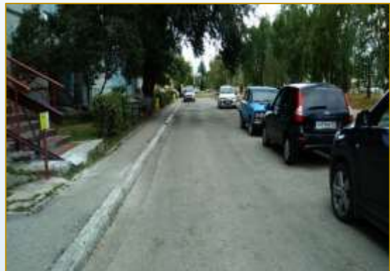
Фото объекта «До»
