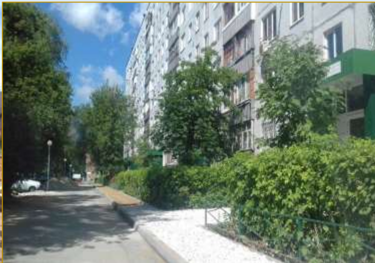
Фото объекта «В работе»
