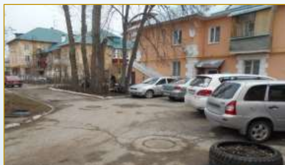
Фото объекта «До»
