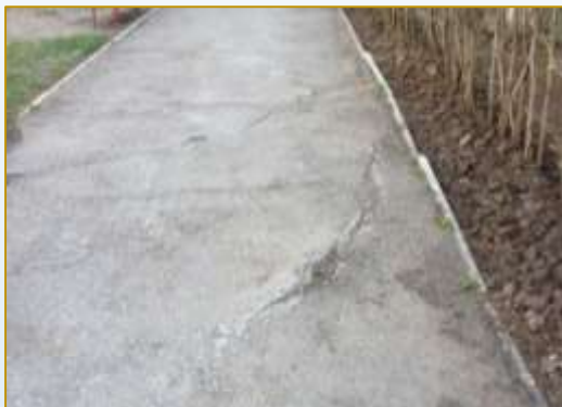
Фото объекта «До»
