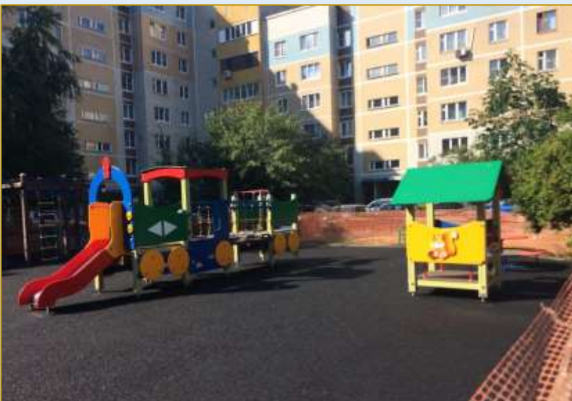
Фото объекта «В работе»
