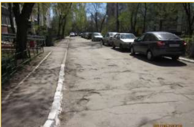
Фото объекта «До»
