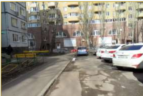
Фото объекта «До»
