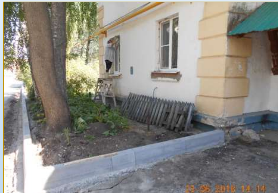
Фото объекта «В работе»
