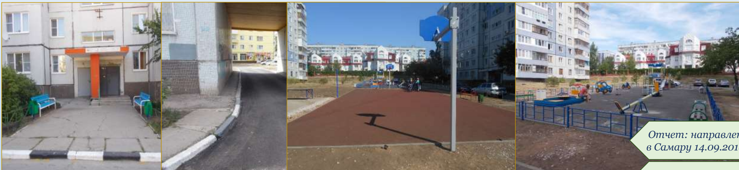
Фото объекта «В работе»
