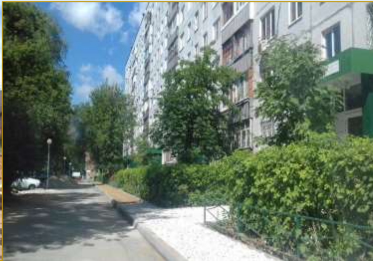
Фото объекта «В работе»
