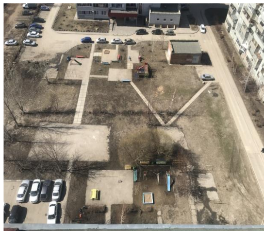
Фото объекта «До»
