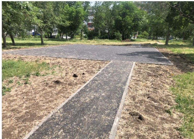
Фото объекта «В работе»
