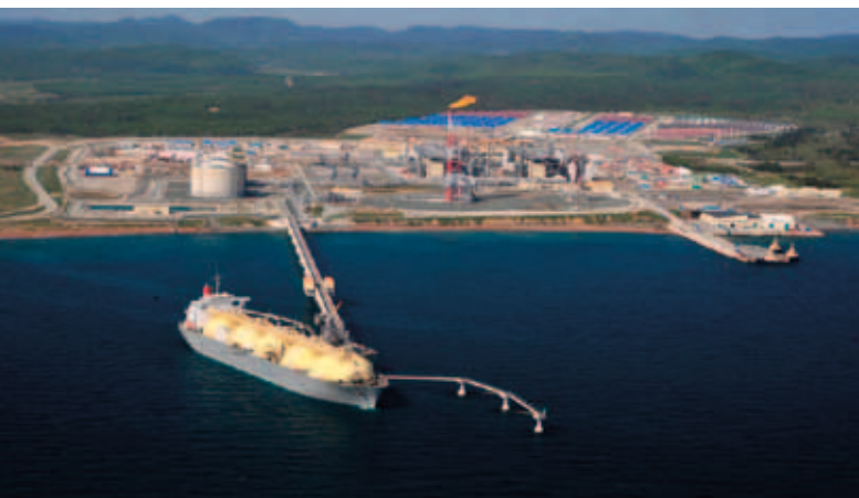
Производственный комплекс «Пригородное» — завод СПГ/ТОН (терминал отгрузки нефти)
